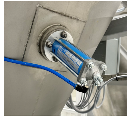
Bild 1 pneumatischer singold-Klopfer K 40
